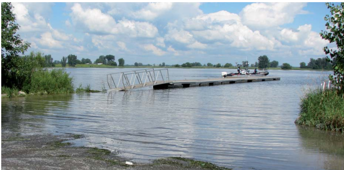
La rampe de mise à l'eau, située sous la ligne de transmission d'Hydro-Québec dans l'arrondissement de Rivière-des-Prairies-Pointes-aux-Trembles, était submergée le 11 août 2008.
